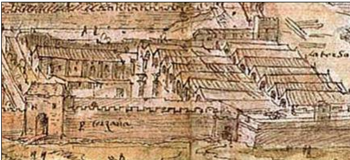
Detall de les drassanes segons Van den Wyngaerde. Es pot observar com al pati posterior hi ha una sèrie de pilars en construcció.
