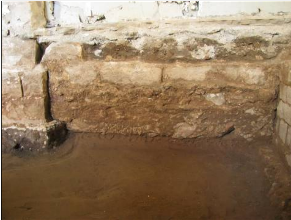
Mur UE 1463 recolzant-se en mur UE 1450 i pilar UE 1541.
