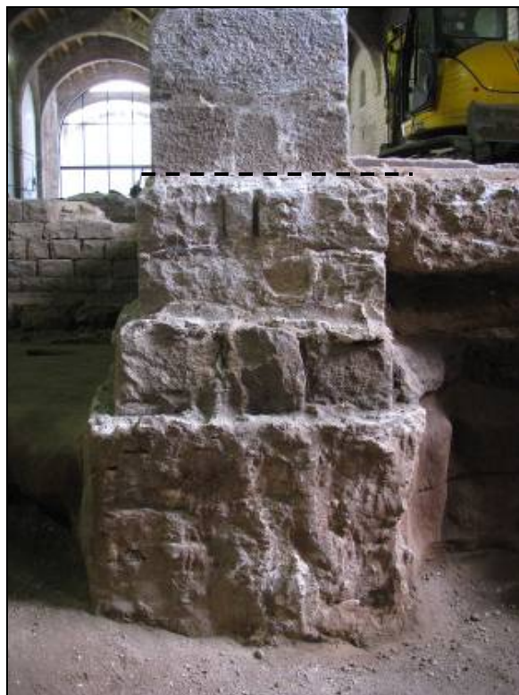
Basament i pilar UE 1656 (s. XIV) sota pilar UE 1648 (s. XVI).
