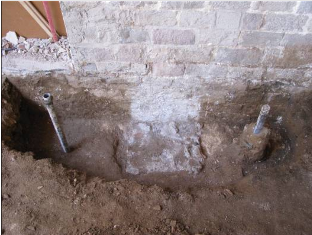
Estructura UE 1594 afectada per encepat 10.
