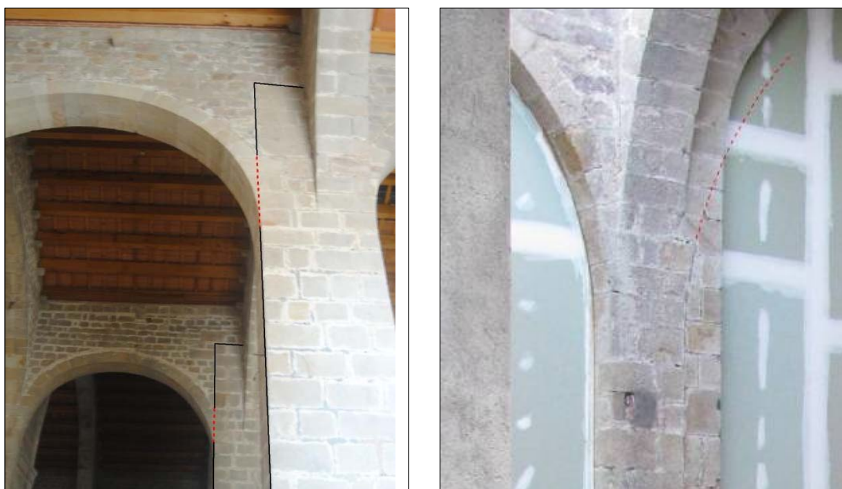
Arcs del segle XVII. Arrencament des dels contraforts de façana del segle XVI (esquerra) i entrega als arcs del segle XIV (dreta).
