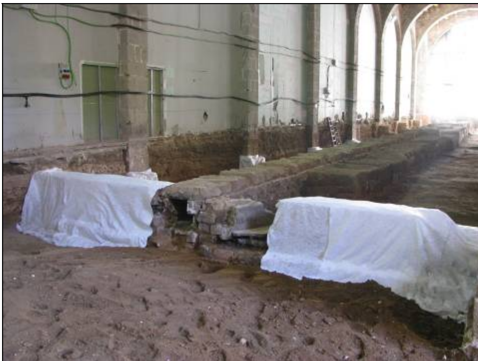
Protecció del mur UE 1450 documentat a les rases 1 i 2 amb rasa 7.
