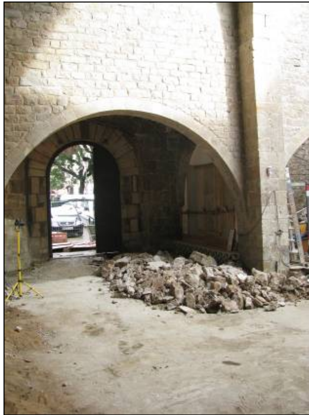
Obertura del sondeig a l'accés a la drassana.
