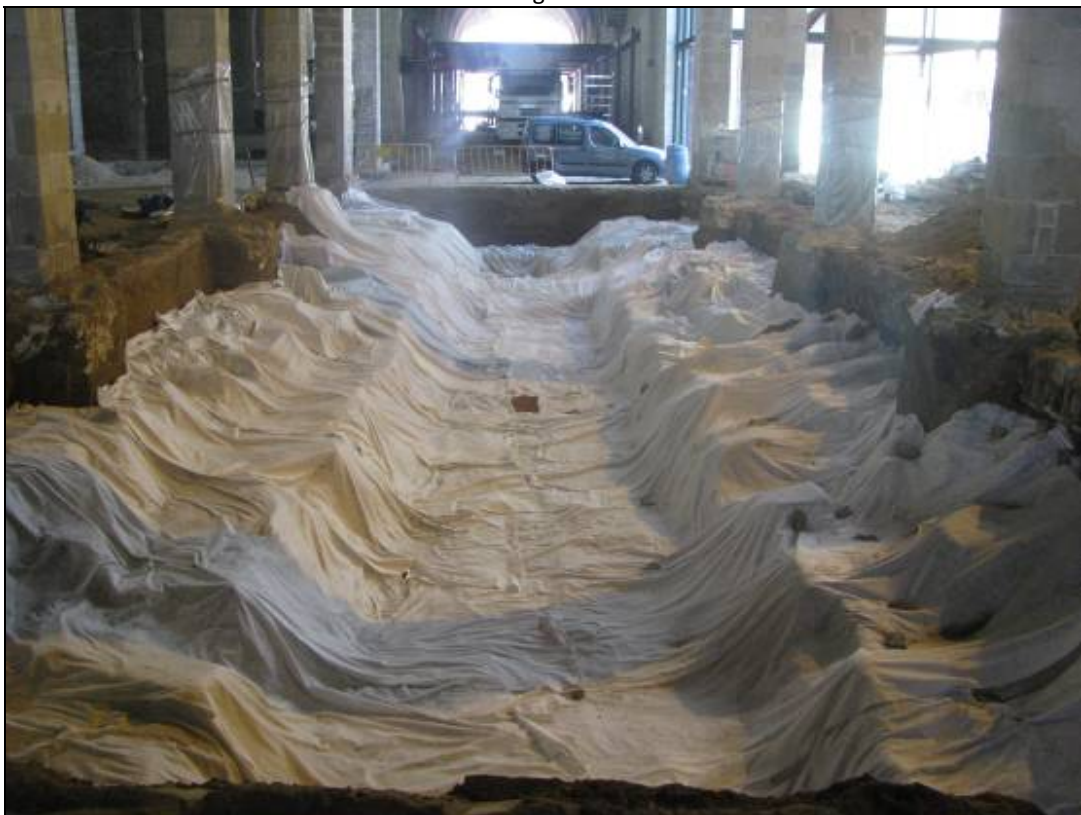
Cobriment amb geotèxtil de l'estructura UE 1252.
