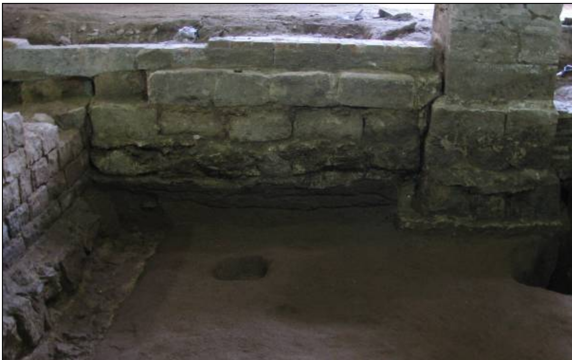
Mur UE 1704 recolzant-se al mur de tancament de la drassana (esquerra) i al pilar UE 1656 de les naus sobiranes (dreta).
