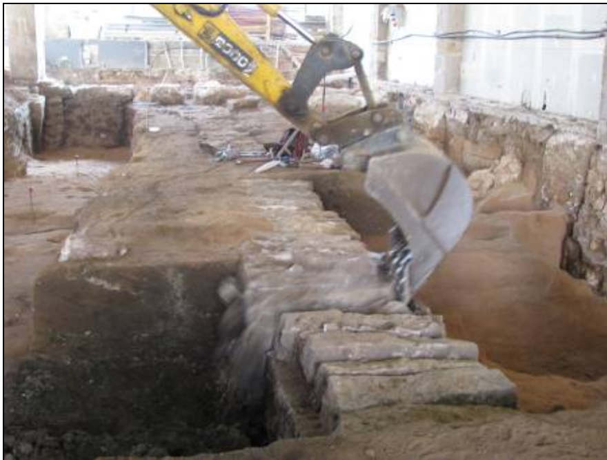
Desmuntatge amb màquina de col·lector UE 1110.
