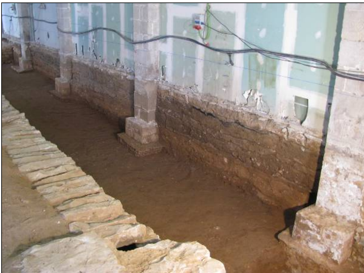
Basaments de pilar de les naus sobiranes de Pere el Cerimoniós sota els pilars de les naus construïdes al segle XVI.
