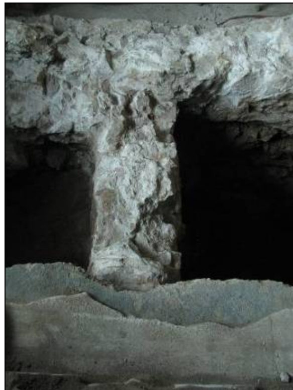
Tram de mur UE 1805 afectat per la rasa 3.
