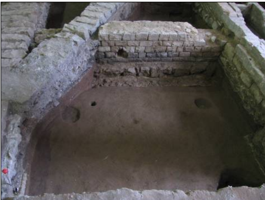
Mur UE 1450 a la rasa 2 amb rasa 7. Cara interna.
