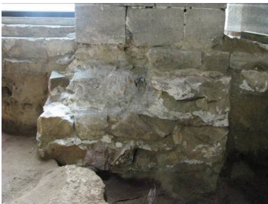
Basament de façana UE 1747.
