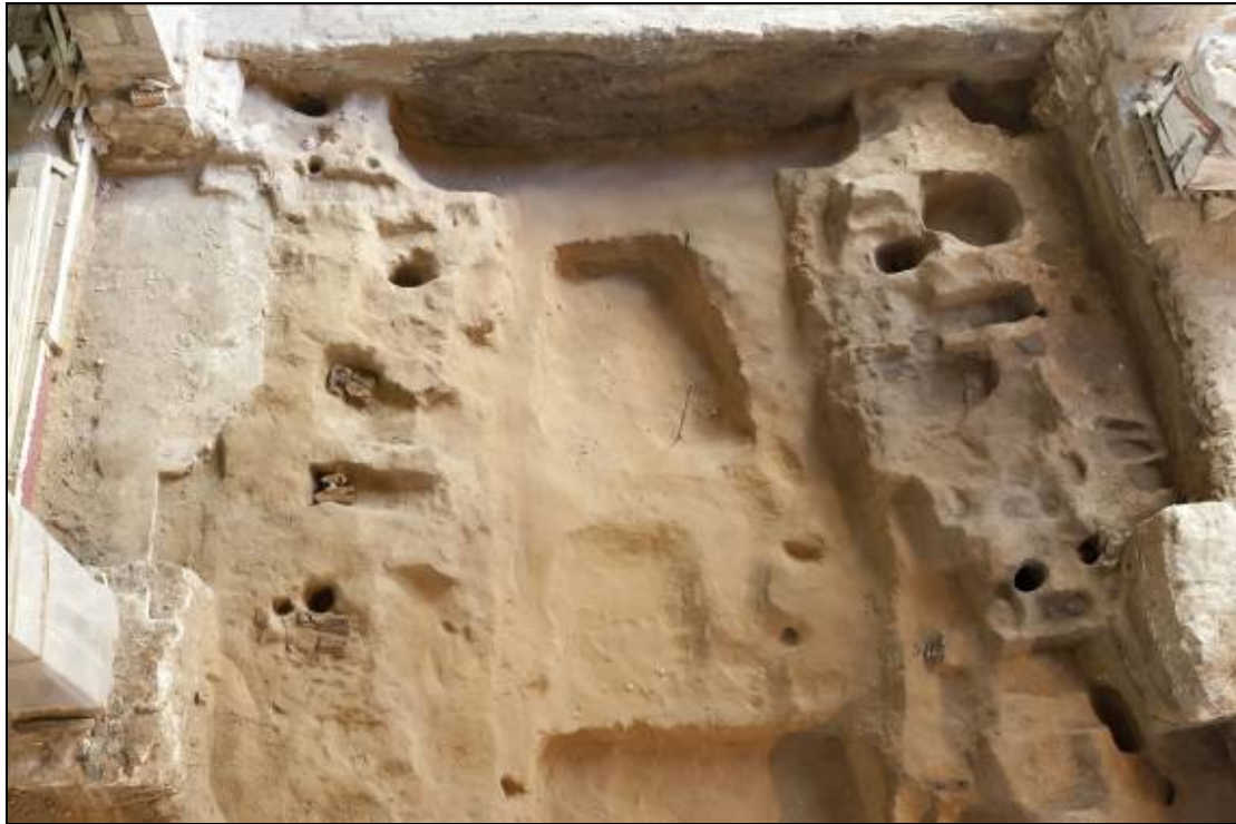
Escar de construcció de galeres. Detall encaixos.
