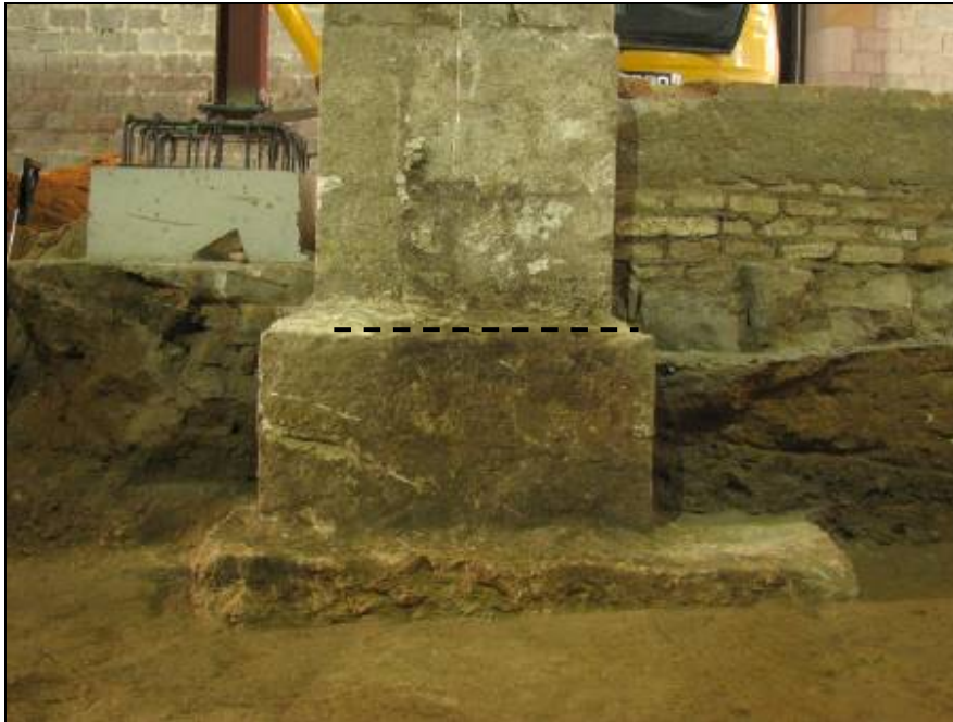
Basament i pilar UE 1591 (s. XIV) sota pilar UE 1590 (s. XVI).
