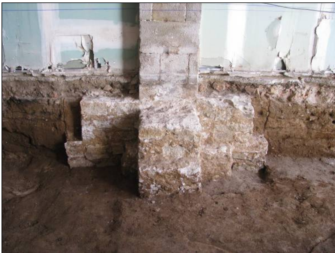
Un dels reforços a nivell de fonamentació aplicat a un pilar del segle XVI per tal d'aixecar el nou pis.
