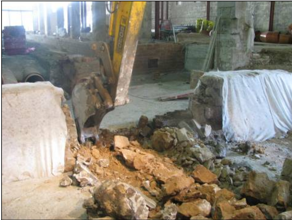
Enderroc del col·lector modern UE 1110 i la part afectada del mur UE 1450.
