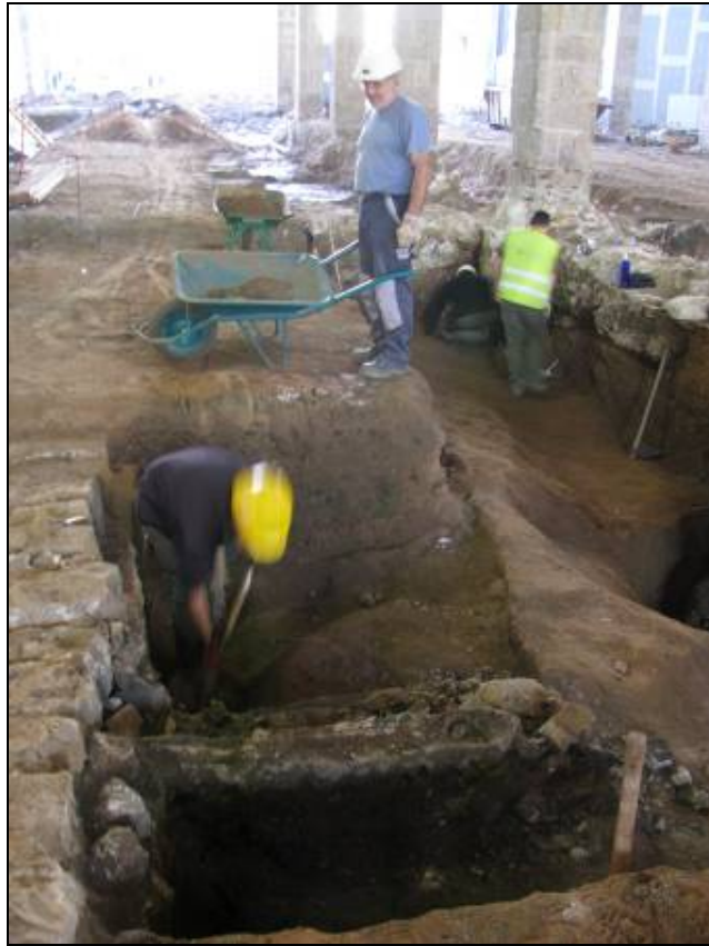
Desmuntatge manual de claveguera 1113.
