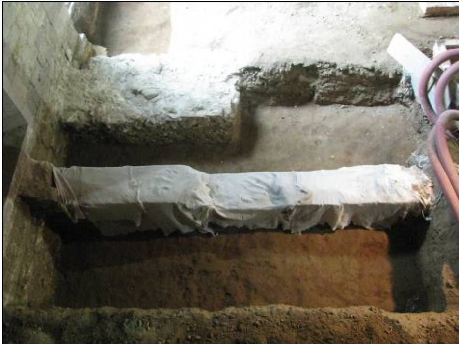
Protecció del mur UE 1450 documentat a la confluència de les rases 3 i 4 amb la rasa 7. Nau central.
