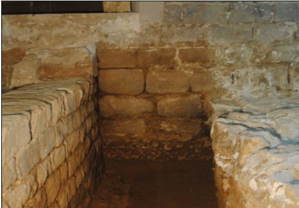
Mur UE 1849 recolzant-se en mur UE 1450.
