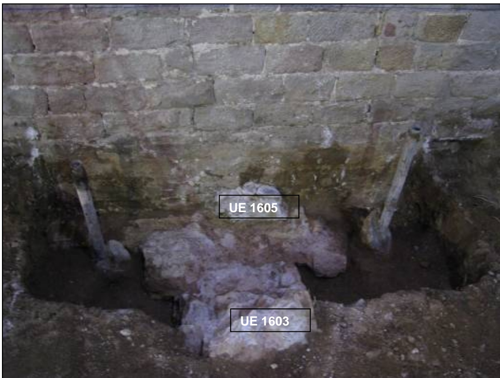
Estructura UE 1605 i mur UE 1603 afectats per l'encepat UE 15.
