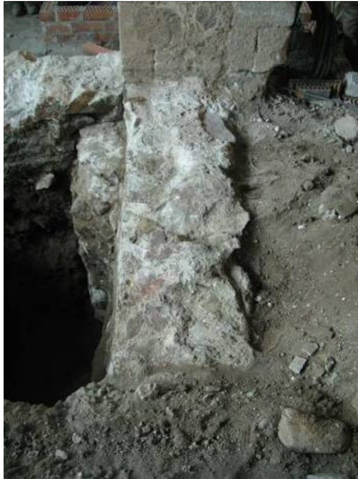
Tram de mur UE 1807 afectat per la rasa 3.
