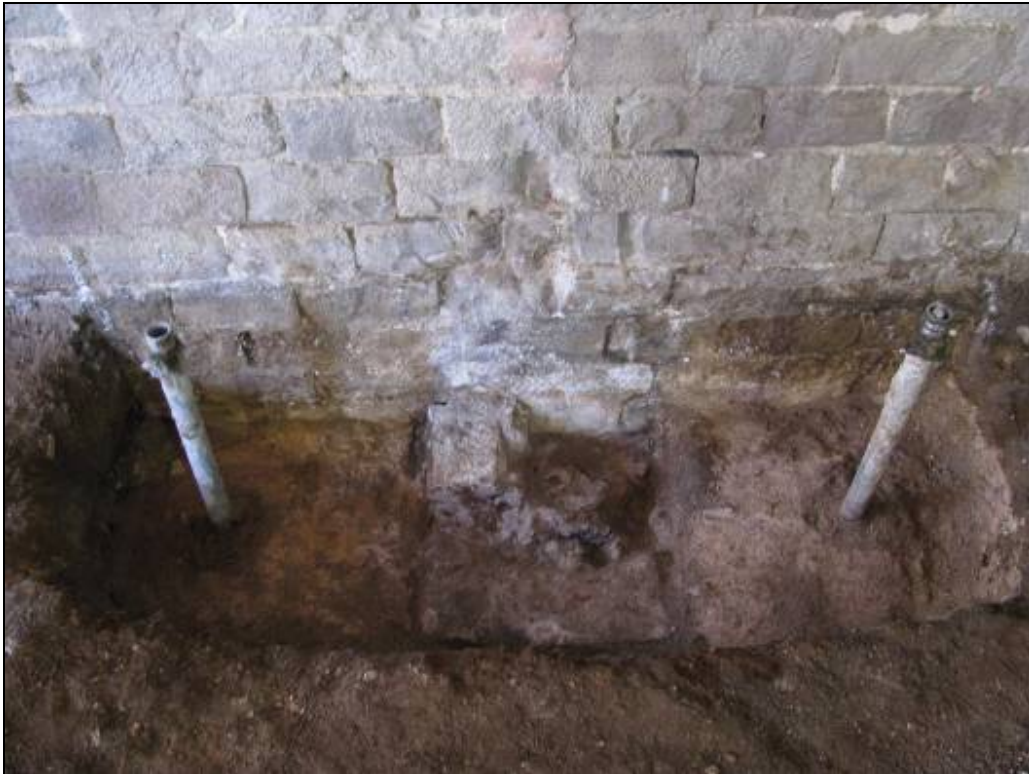
Estructura UE 1595 afectada per encepant 12.
