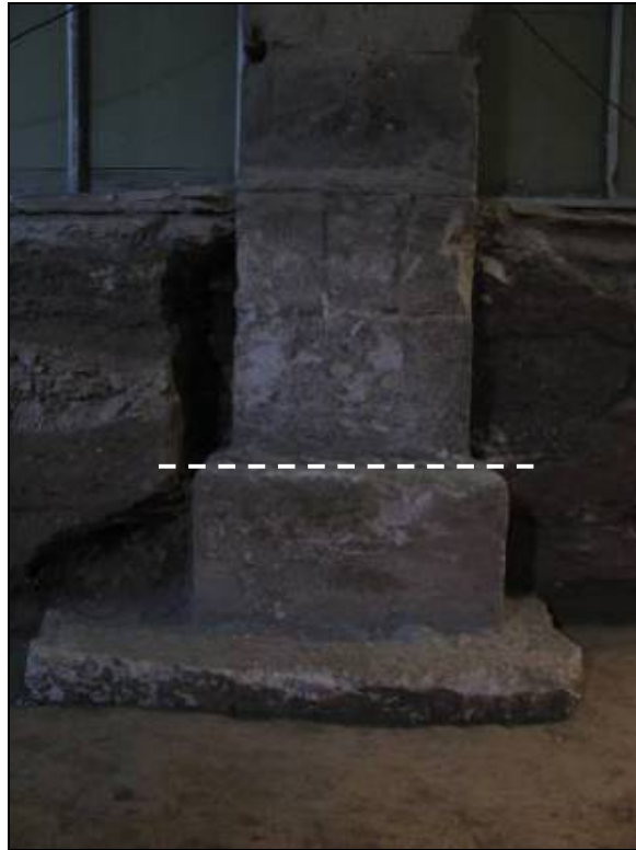
Basament i pilar UE 1543 (s. XIV) sota pilar UE 1424 (s. XVI).
