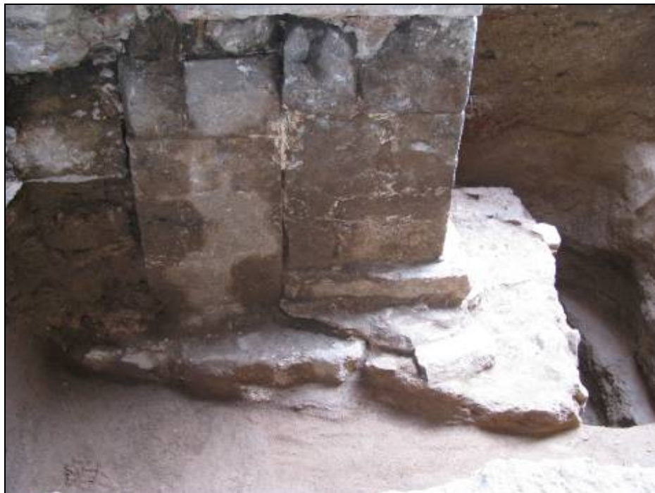
Pilar del pòrtic UE 1382 (segle XIII)-esquerra- i pilar de la coberta del cos de mar del Cerimoniós UE 1380 (segle XIV) –dreta-.
