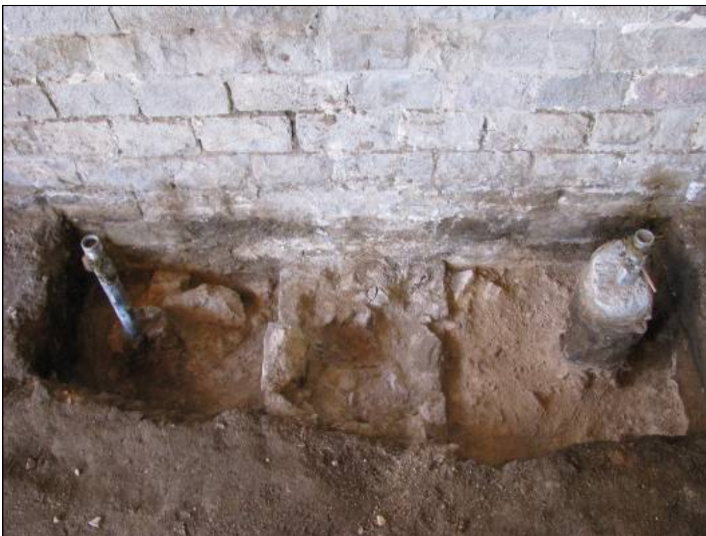
Mur UE 1574 afectat per l'encepat 11.
