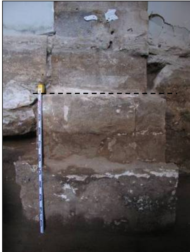
Basament i pilar UE 1541 (s. XIV) sota pilar UE 1421 (s. XVI).
