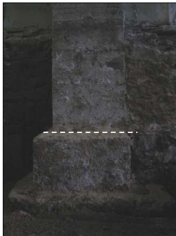
Basament i pilar UE 1669 (s. XIV) sota pilar UE 1517 (s. XVI).
