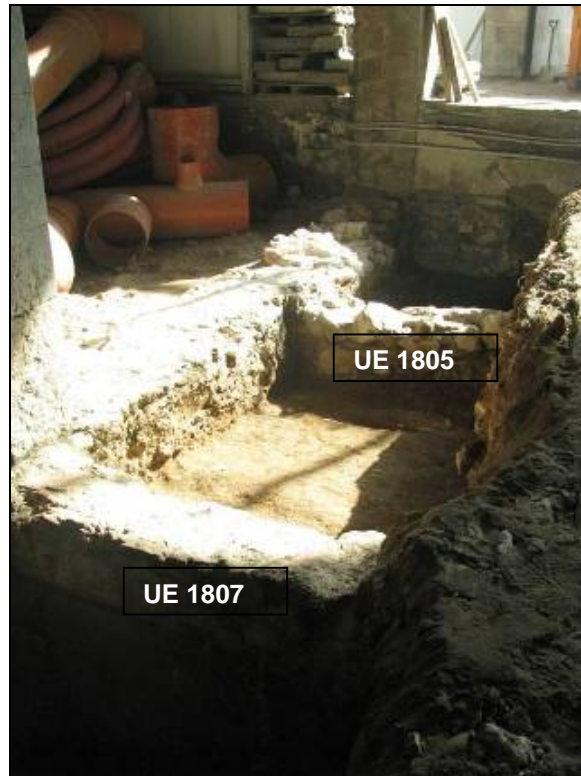
Trams dels murs UE 1805 i UE 1807 afectats per la rasa 4.
