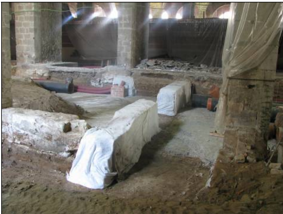
Segments del mur UE 1450 conservats a la nau meridional. Rasa 7
