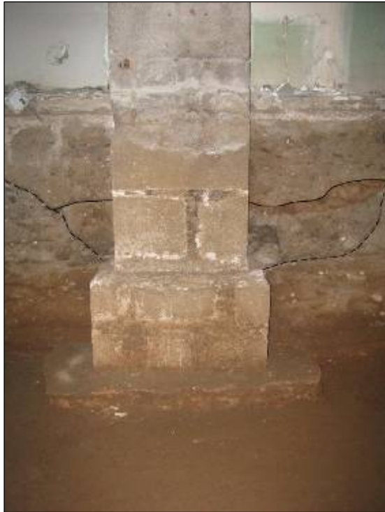
La rasa de fonamentació (línia discontinua) afecta l'estratigrafia dels segles XV i XIV. En topiar amb els basaments gòtics, recolzen directament els pilars moderns.
