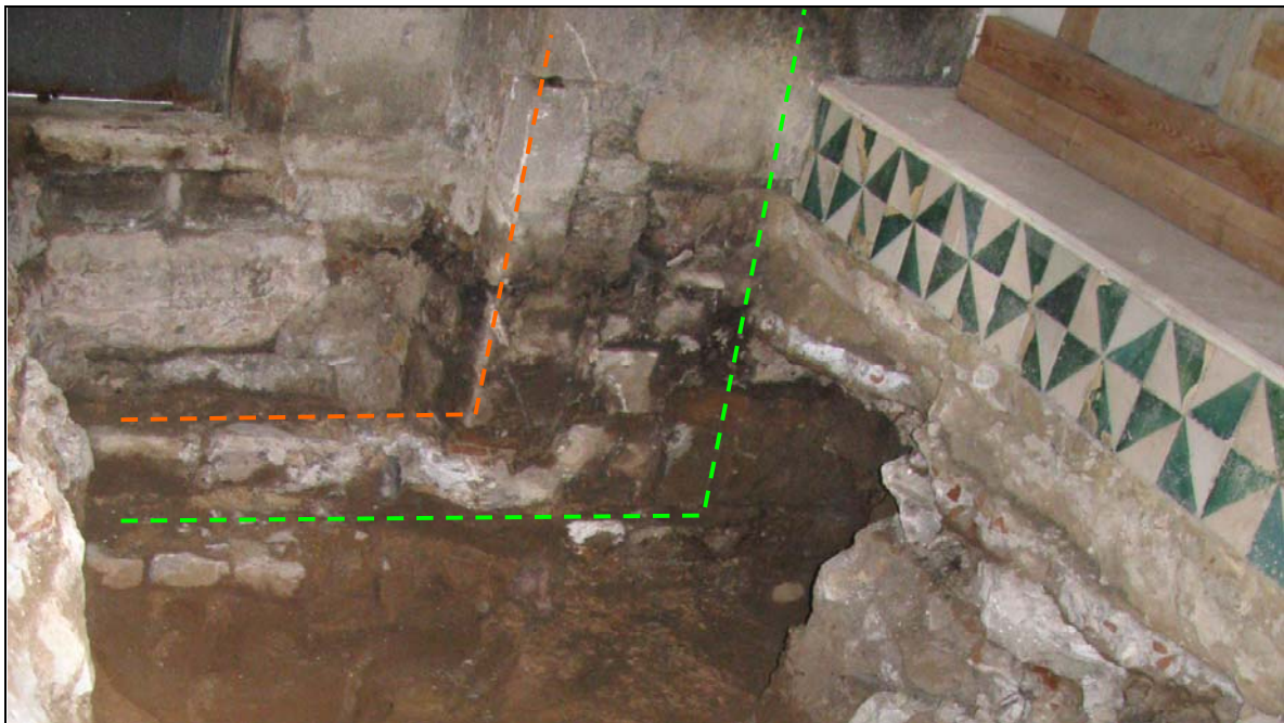
Part inferior de l'accés. Es remarca en color verd el sòcol i arrencament del segle XIII i en color taronja la reforma d'època moderna.
