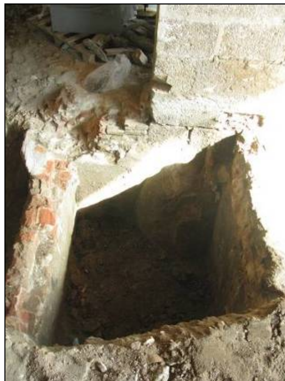
Tram de la fossa sèptica UE 1816 afectada per la rasa 4.
