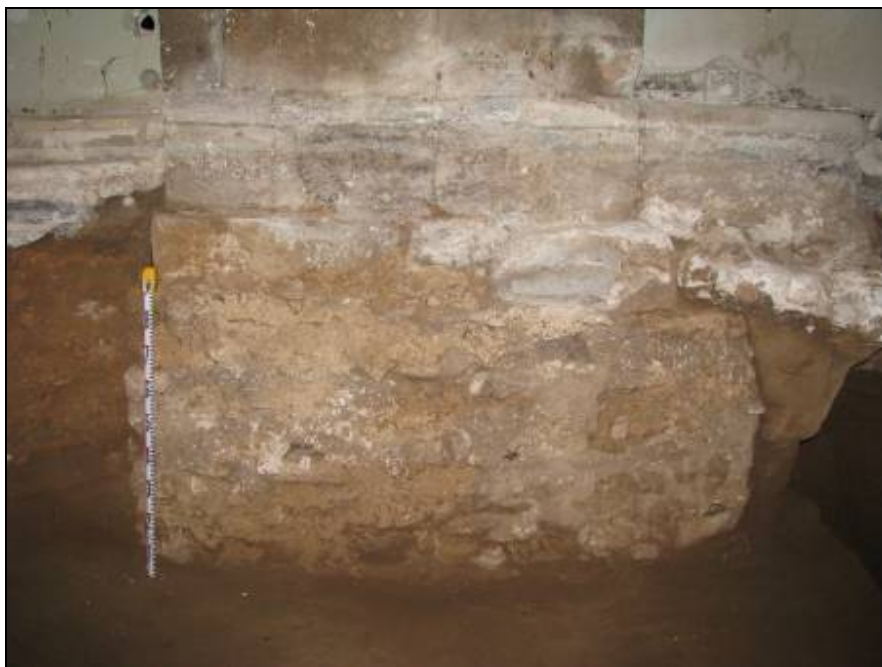
Fonamentació i arrencament de pilar de façana del segle XVI.
