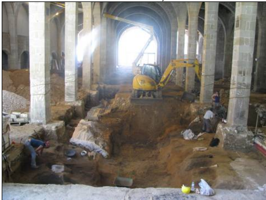
Feines d'excavació i neteja.
