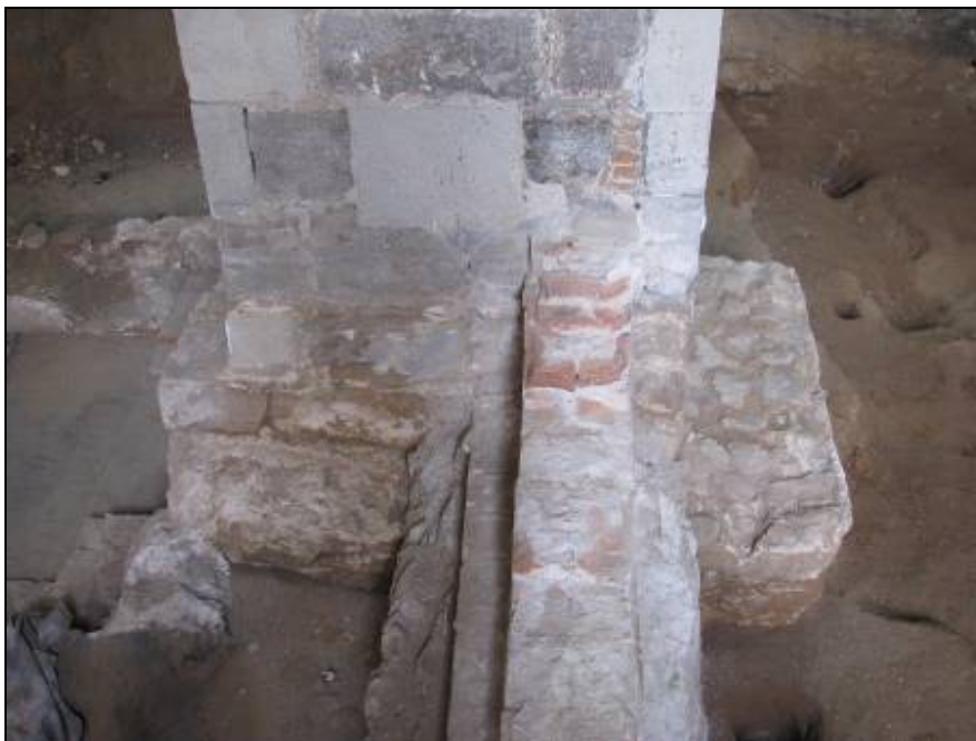
Basament de façana UE 1706.
